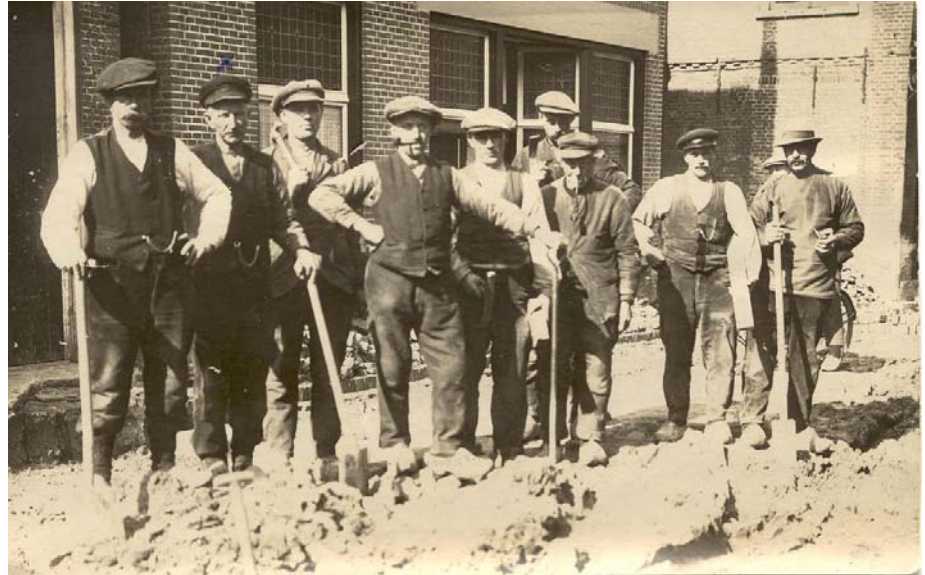
Dit zijn een aantal 'harde werkers' in Oosterbierum die met de straat bezig zijn. Zijn er nog mensen onder ons die deze personen herkennen en wanneer deze werkzaamheden zijn uitgevoerd.
