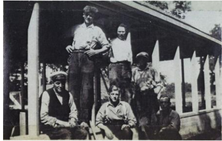
Bouw van een poterbewaarpplaats door personeel van bouwbedrijf Zaagsma uit Sexbierum (foto H. Zaagsma).
