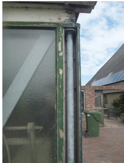
Hoekstijl versterkt met ijzeren buis, Klooster-Lidlum, Kleasterwei 21 (foto R.J. Wielinga).
