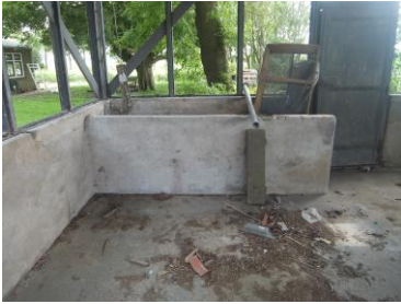
Betonnen wasbak om aard-appelen te behandelen tegen Rhizoctonia, Minnertsga, Hoarnestreek 4 (foto R.J. Wielinga).
